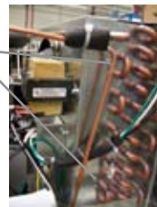
机组安装螺丝
