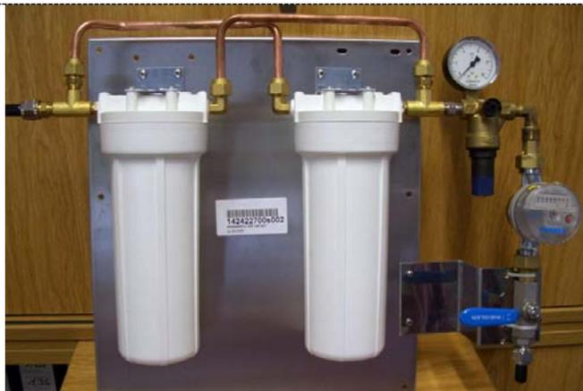
Foto 9: Conecte la red de agua a la estación de filtrado de agua.
