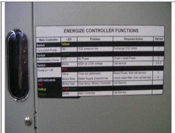
Foto 16: Etiqueta que explica las funciones del controlador cerca del controlador A
