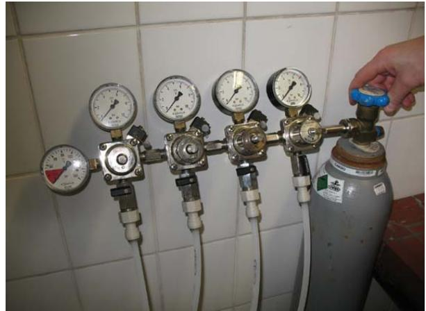
Foto 2: Botella de CO2 con un montaje del regulador de CO2 correcto.
