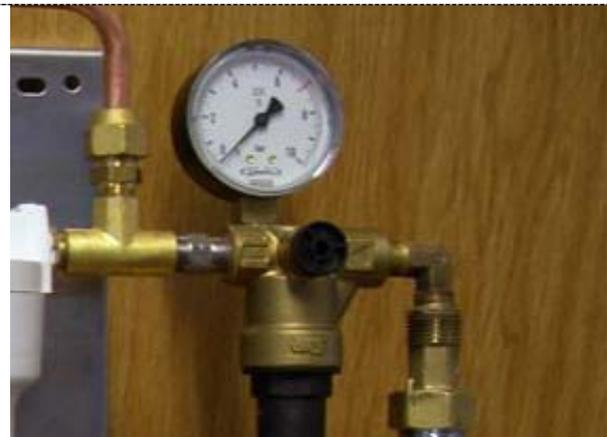
Foto 10: Compruebe la presión del agua de la toma.
